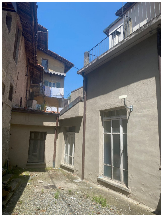
FOTO 14 - SCATTATA DAL LATO NORD OVEST
