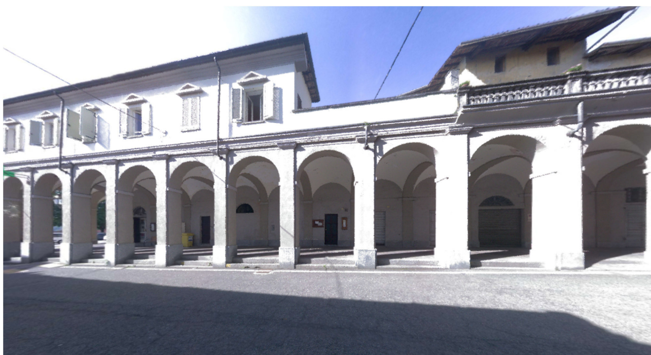
FOTO 1 – SCATTATA SUL LATO NORD
