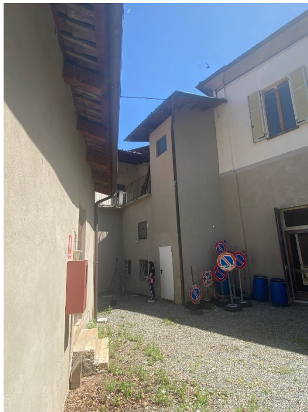
FOTO 12 – SCATTATA DAL LATO OVEST
