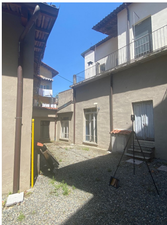
FOTO 13 - SCATTATA DAL LATO NORD OVEST
