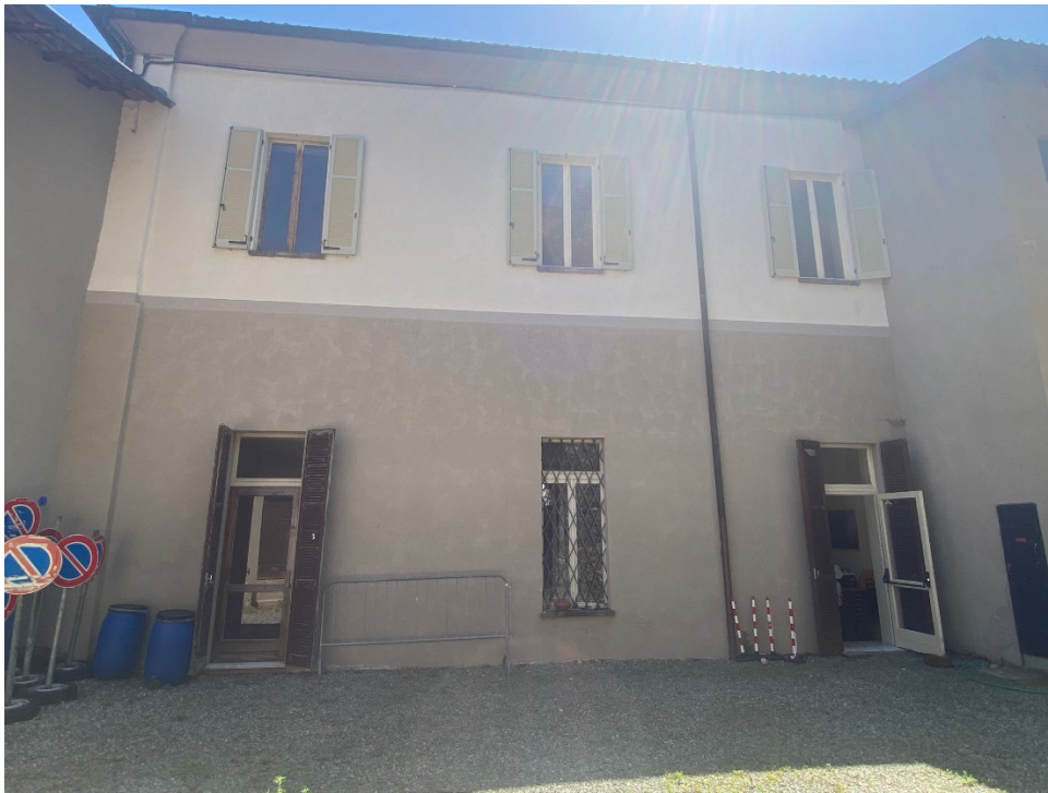
FOTO 11 – SCATTATA DAL LATO OVEST
