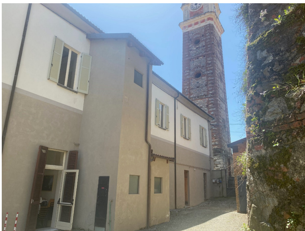
FOTO 10 – SCATTATA DAL LATO OVEST
